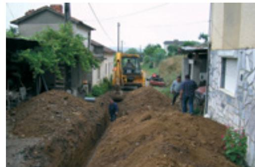
Remoção da travessia de esgoto existente em Coja, no Rio Alva, e colocação de uma nova solução de carácter transitório.
