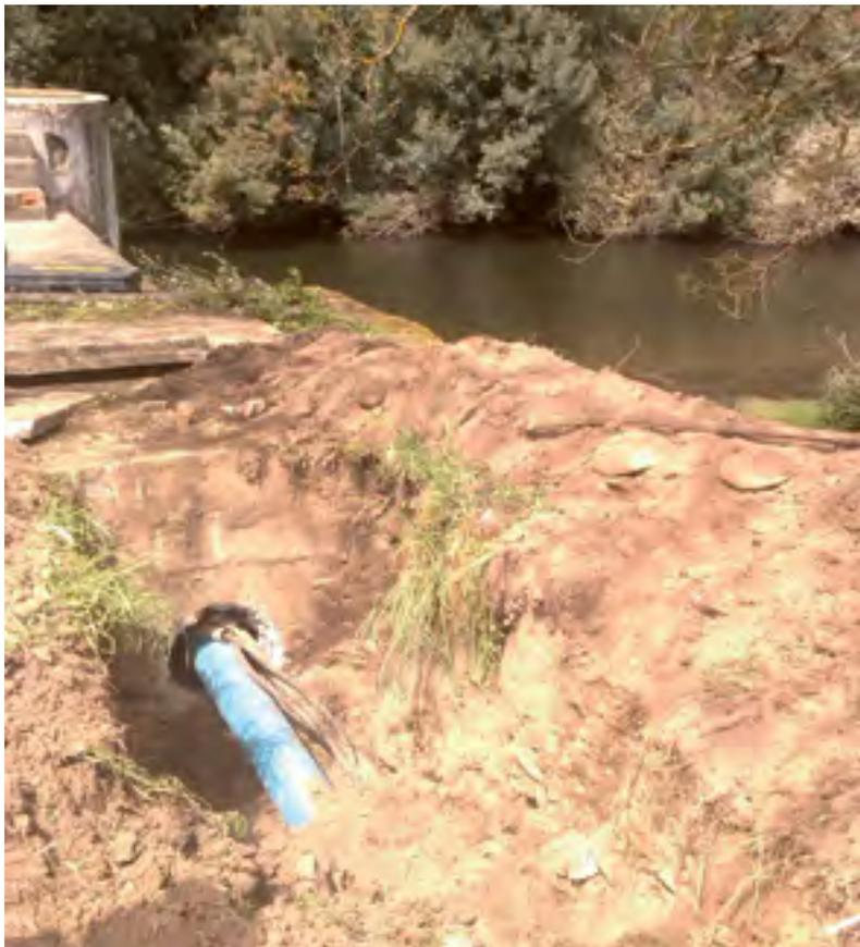
Substituição de conduta de captação de água em Vila Cova de Alva.
