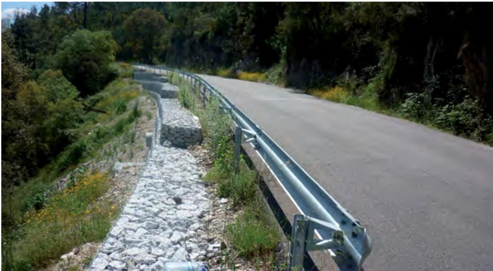
Construção de muro de suporte e pavimentação de troço da Estrada Côja - Barril de Alva.
