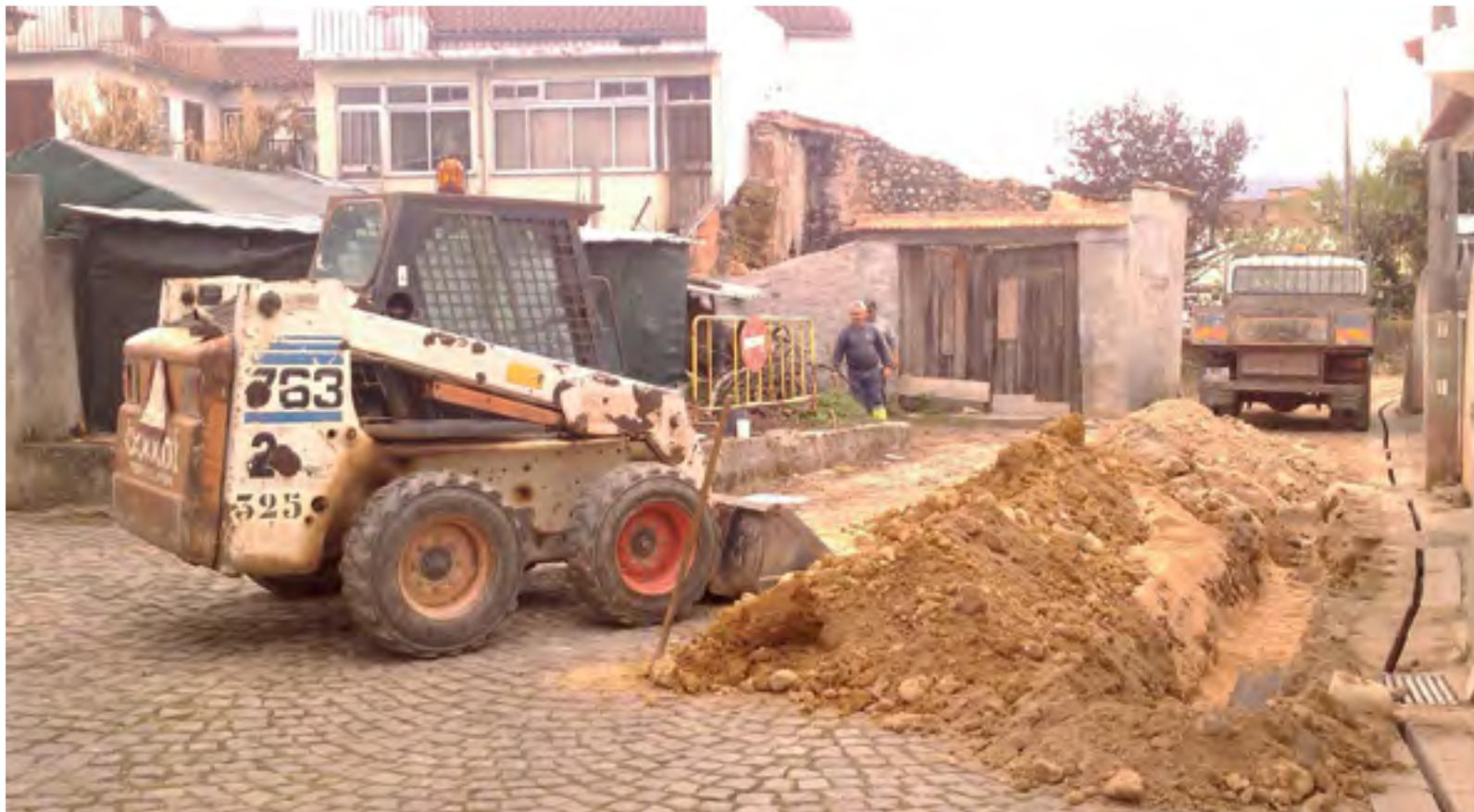
Construção de sistema de elevatórias de saneamento em Sarzedo para ligação à ETAR da Alagoa.
