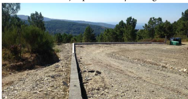
Trabalho para construção de Parque de Resíduos Sólidos Urbanos em Mourísia (parceria com a União de Freguesias de Cerdeira e Moura da Serra e Junta de Freguesia de Piódão)
