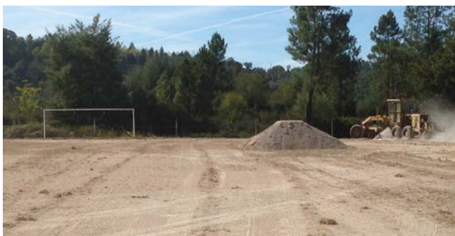
Reparação do pavimento do Campo de Futebol do Grupo Desportivo Vilacovense
