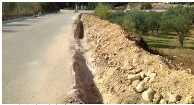
Ampliação da Rede de Abastecimento de Água ao Picadouro e Travesso - Pombeiro da Beira
