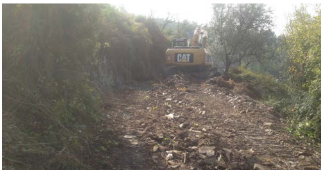
Alargamento de Estrada Florestal em Alqueve - Folques
