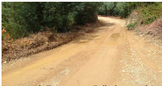
Manutenção de Troços para o Rally de Arganil
