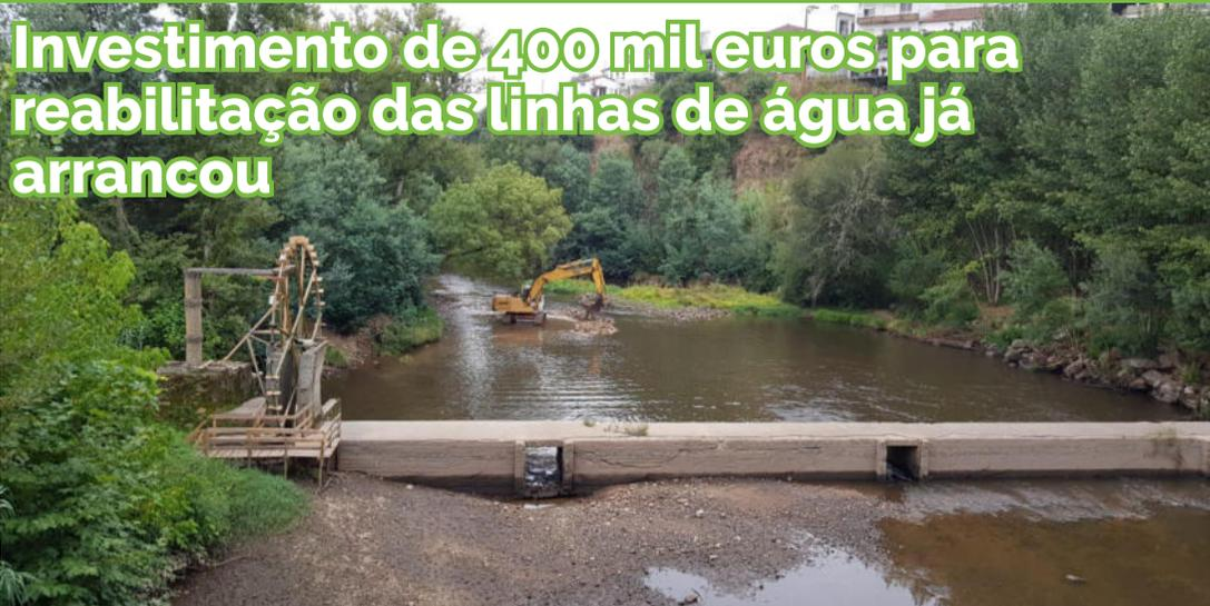
A Câmara Municipal de Arganil iniciou os trabalhos de reabilitação e limpeza das linhas de água nas zonas do concelho afetadas pelo incêndio de outubro do ano passado, tendo em vista a regularização fluvial da Bacia do Rio Alva, o devido escoamento das águas, a redução da erosão e o arrastamento dos solos.
