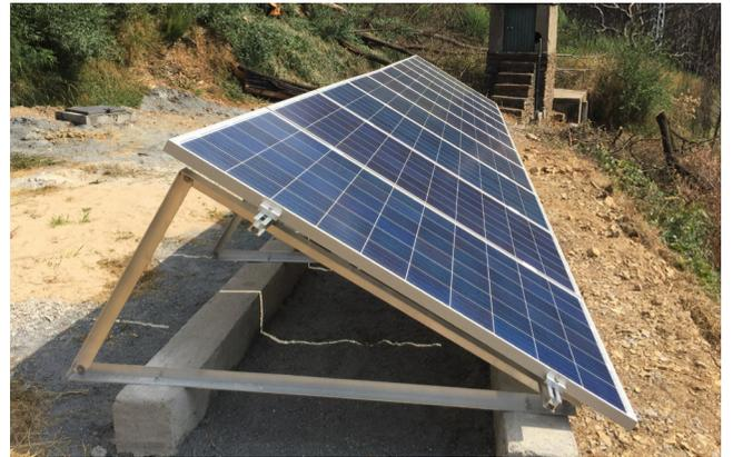
Nova captação de abastecimento de água em Selada das Elras - Cepos com instalação de painéis fotovoltaicos e hidrobomba
