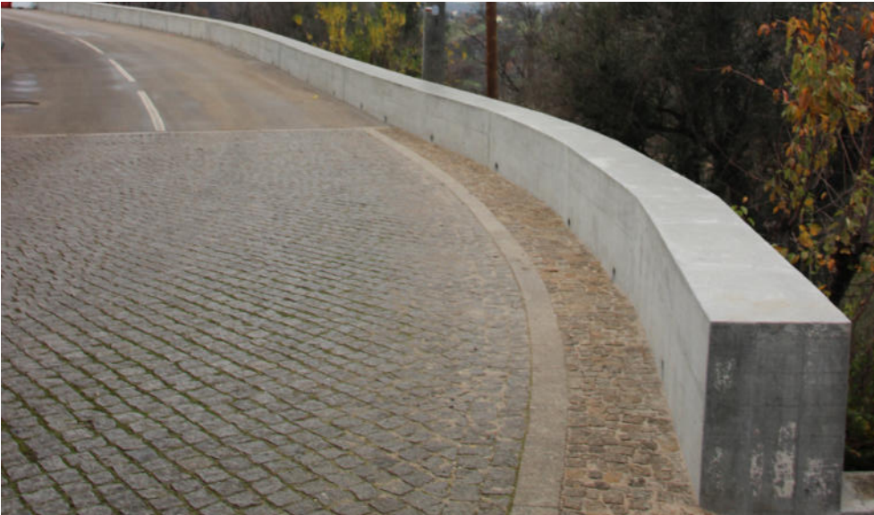
Reabilitação do muro de suporte à EN 342 em Vila Cova de Alva (Infraestruturas de Portugal)
