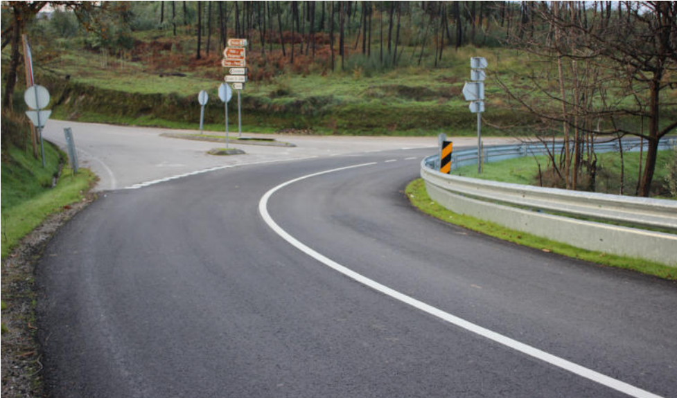
Pavimentação da EN342: Côja - Avô (Infraestruturas de Portugal)
