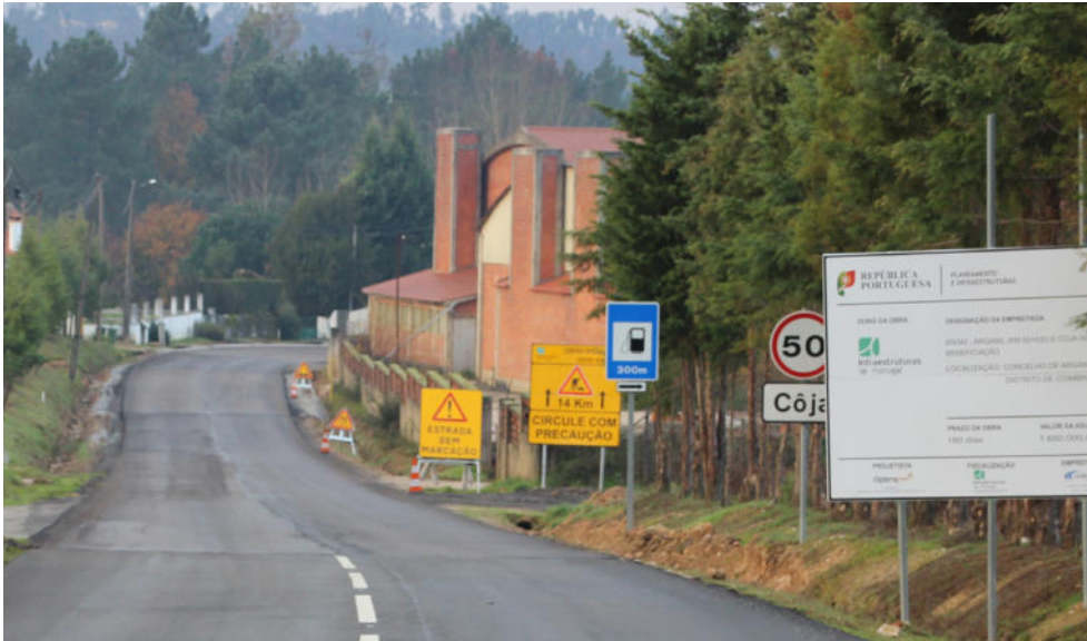
Beneficiação da EN342: Arganil - Côja (Infraestruturas de Portugal)
