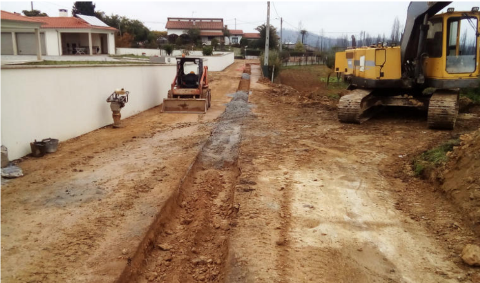
Sistema de águas residuais de São Martinho da Cortiça - interligação da fossa coletiva à ETAR de Poços e construção de rede de saneamento em Vale Matouco e Vale de Moinho
