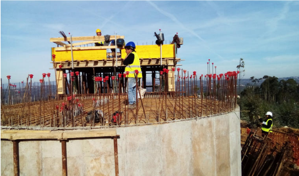
Sistemas de Abastecimento de Água – Subsistema do Bufalhão - Novo reservatório de 80m³
