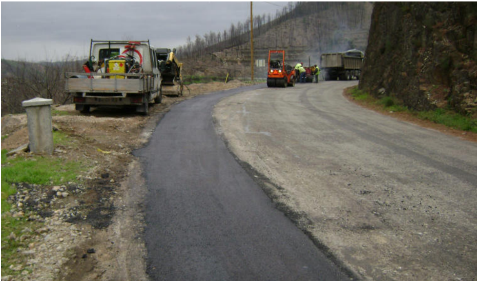
Nova conduta adutora de água: Cerdeira, Dreia, Deflores e Benfeita
