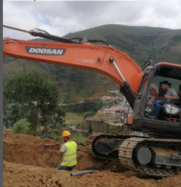
INSTALAÇÃO DE CONDUTA EM POMARES
