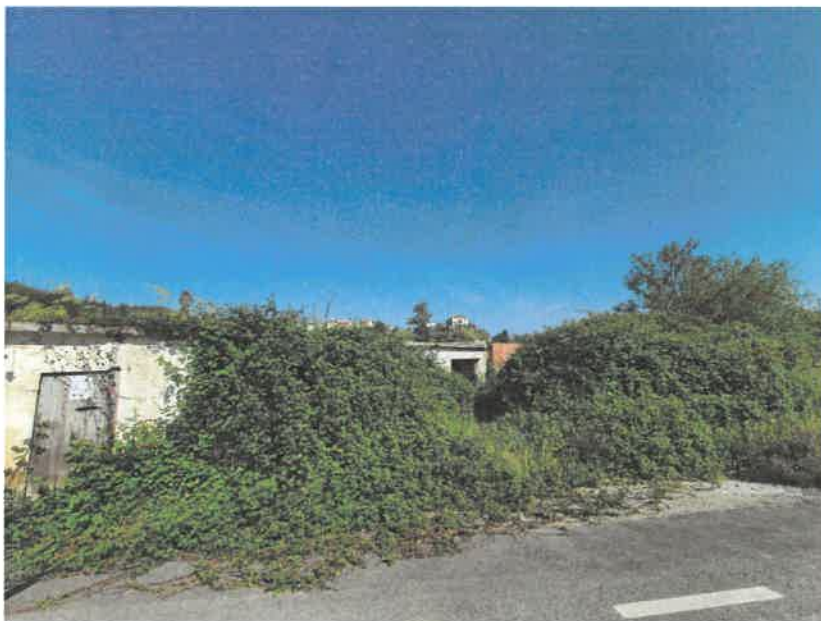
----- Foto n.º5: Falta de gestão de combustível.-----
