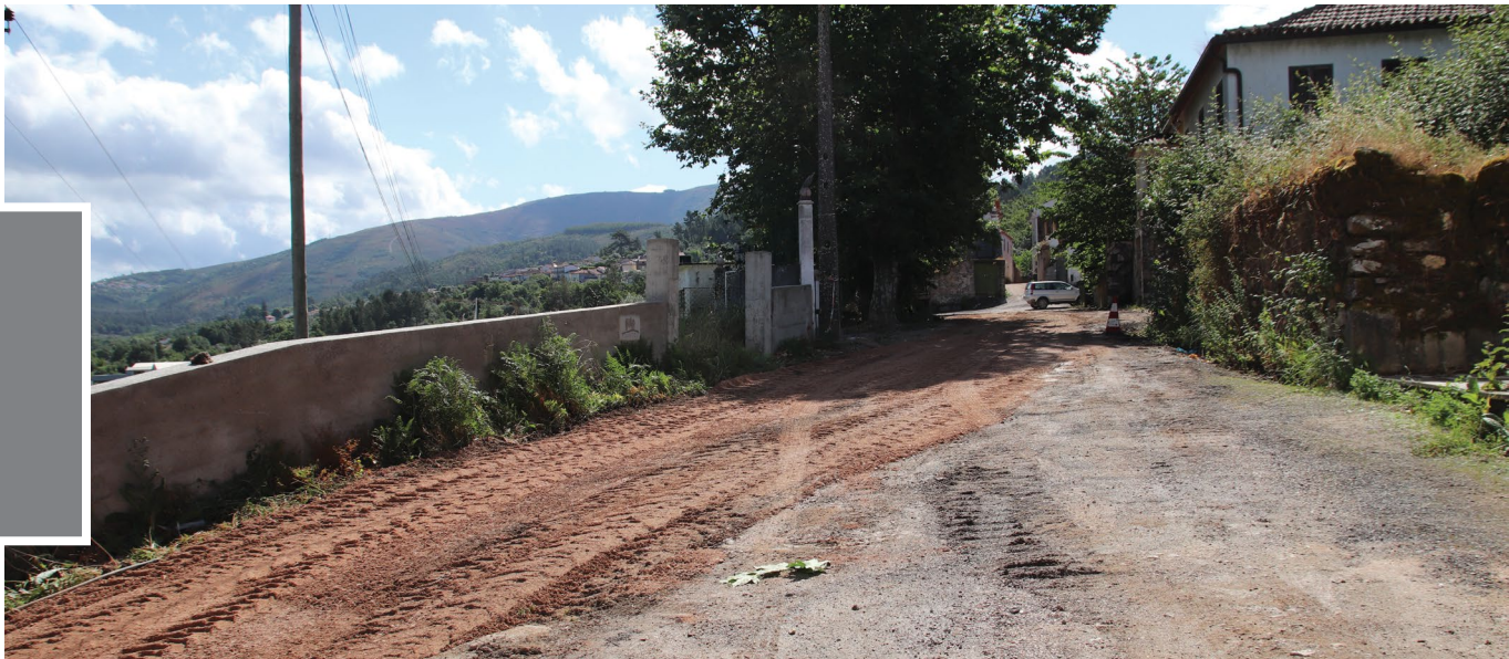
Trabalhos preparatórios para pavimentação em Valbona (Arganil)
