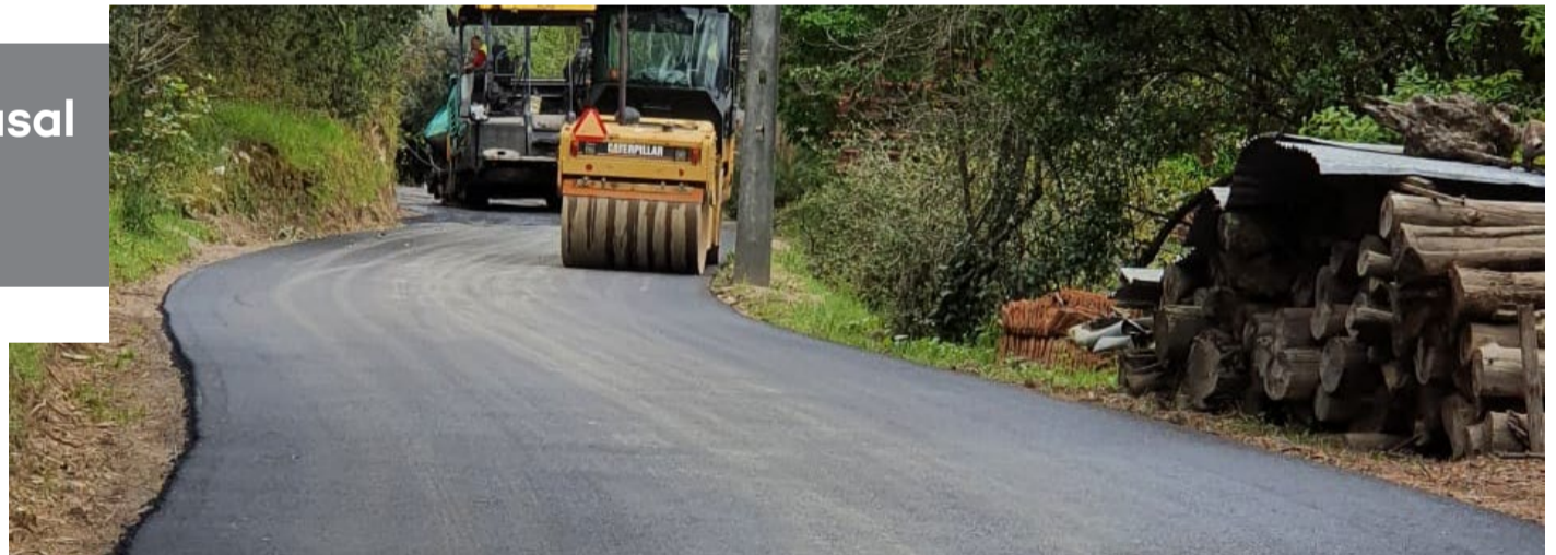
Trabalhos preparatórios do acesso ao Estaleiro Municipal (Arganil)
