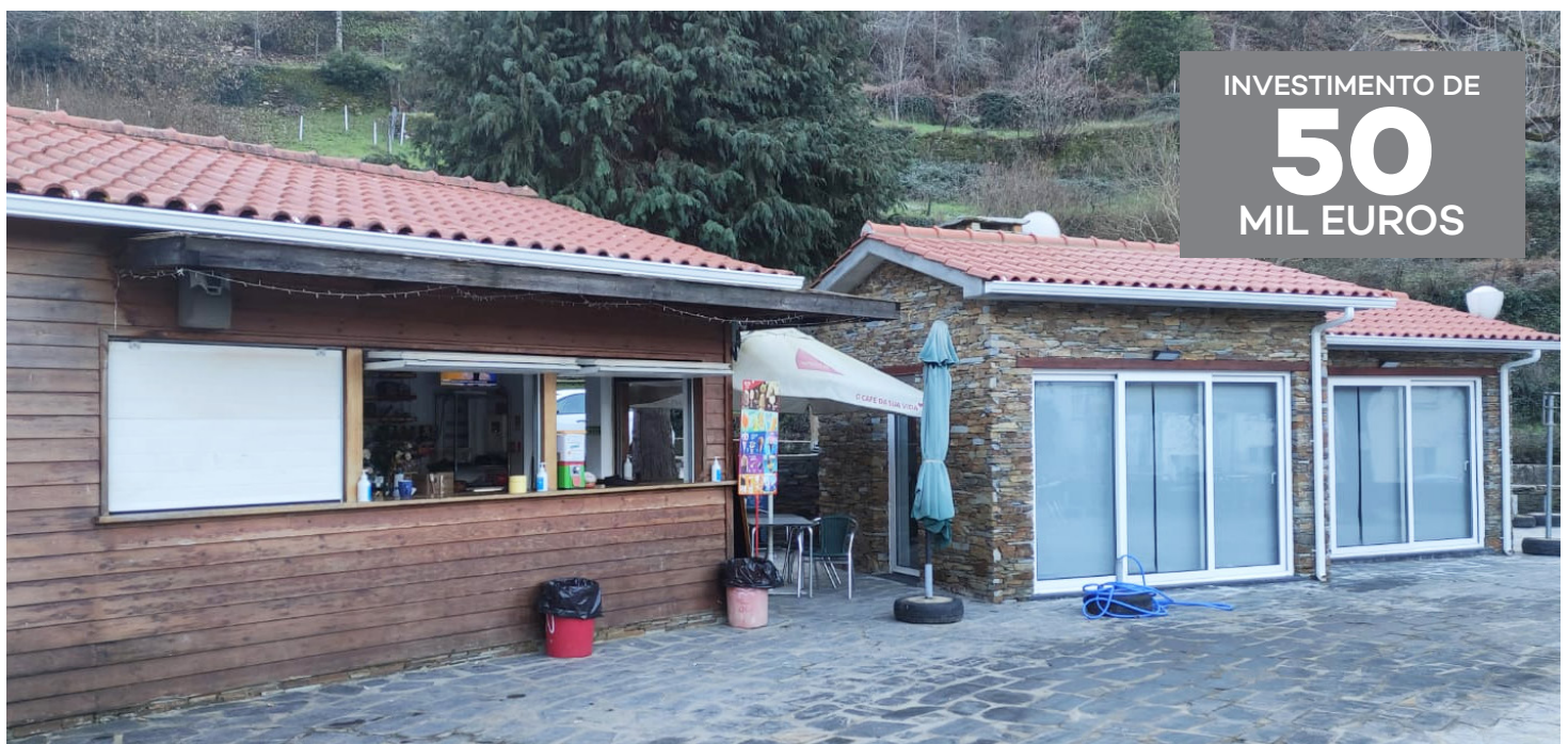
Edifício de apoio ao Quiosque (à direita)
