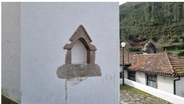
Figura 39 - Envolvente da Torre da Paz - lateral da Capela de Santa Rita
