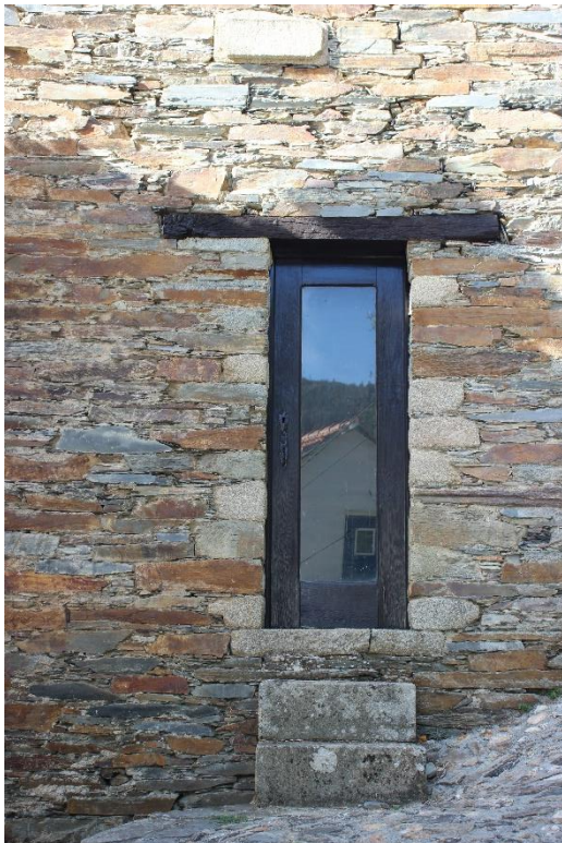
Figura 7 - Porta de acesso no alçado principal
