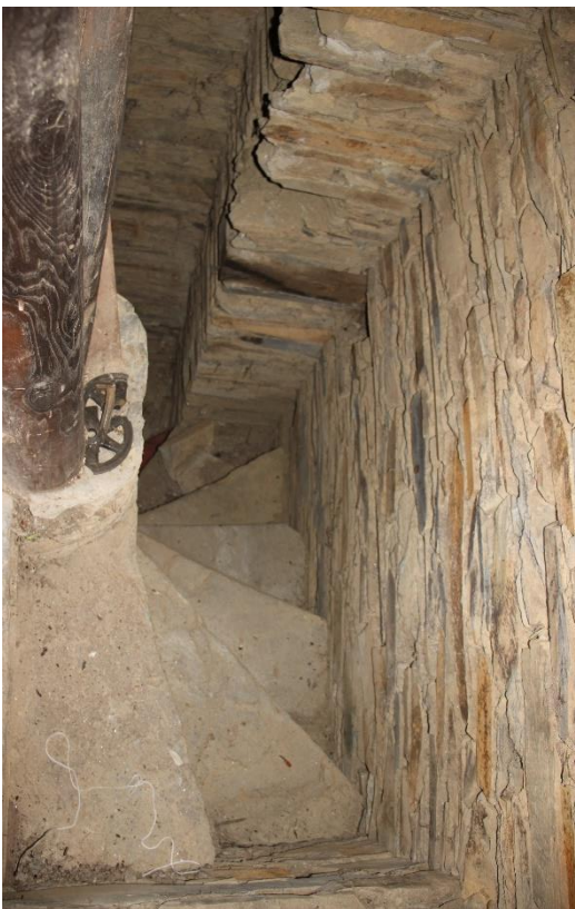
Figura 12 - Escada interior - direção ao piso -1
