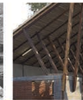
B Telhado de terracota com estrutura de madeira
